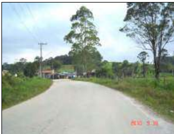
Estrada Verava, bairro dos Paulos, Ibiúna
