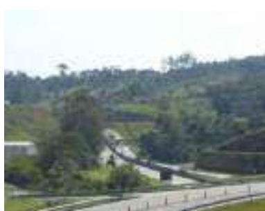
Rod. Raposo Tavares, alt. travessia subadutora Atalaia, em Cotia, px. Frigorífico Patmon
