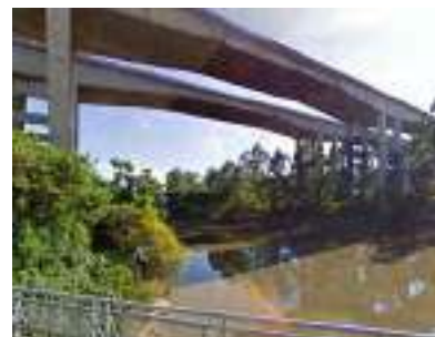
Ponte da rod. Castelo Branco sobre o rio Tietê, alt. foz rio São João de Barueri
