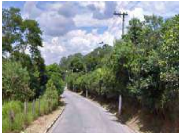
Formações mistas em faixa lindeira da adutora, ao longo da Estrada Antonio João, em Barueri, observando-se sibirunas e eucalyptos.
