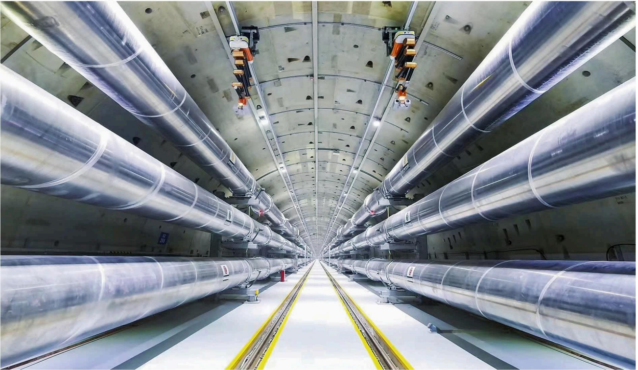
1,000kV Sutong GIL Comprehensive Pipe Corridor Project in Jiangsu, China (Survey and Design) 中国江苏 1000kV 苏通 GIL 综合管廊工程 (勘察设计)
