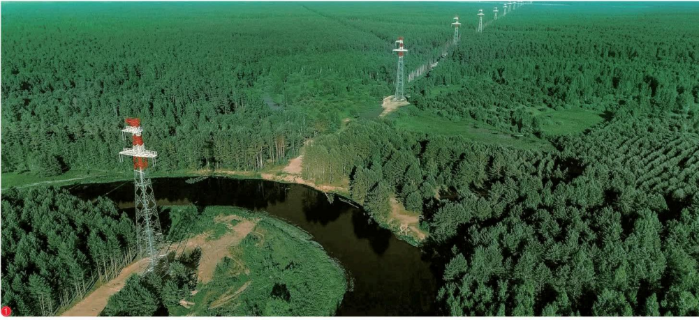
330kV Nuclear Power Output Line and Power Interconnection Project in Belarus (EPC) 白俄罗斯 330kV 核电输出线路及电力联网项目 (工程总承包) 1. Spanning 2,030km and covering over 50% of Belarus's land area, the Project ranks among the largest power grid projects under the energy cooperation framework between China and Belarus. 总长 2030 公里、覆盖白俄罗斯 50% 以上国土面积，中白两国在能源合作方面最大的电网项目之一。
