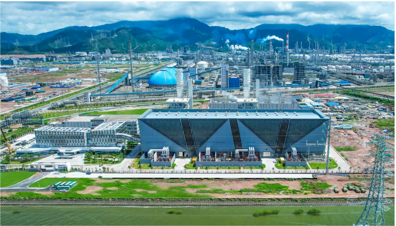
Huizhou Daya Bay Petrochemical Zone Comprehensive Energy Station Project Unit 1 in China (Survey and Design) 中国惠州大亚湾石化区综合能源站项目 1 号机组项目 (勘察设计)
