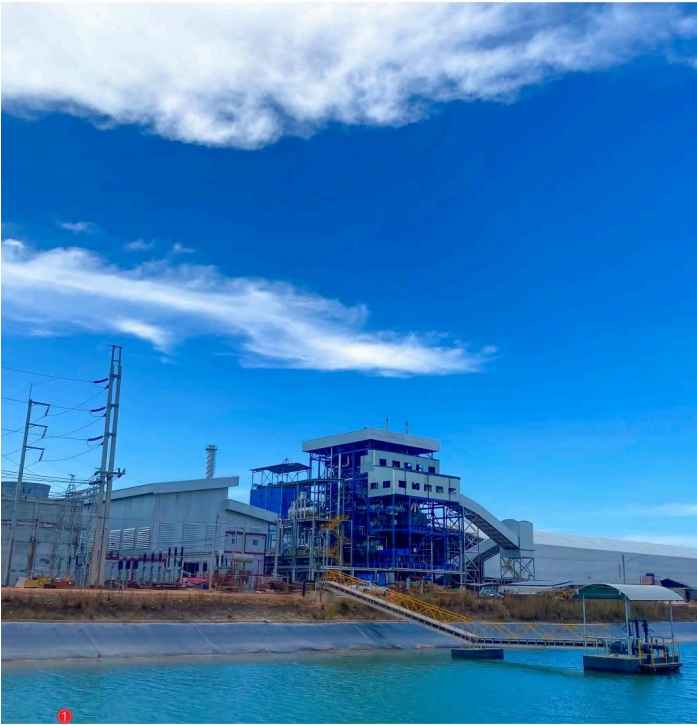
PTG Biomass Power Station Project in Thailand (EPC) 泰国 PTG 生物质电站项目 (工程总承包)
