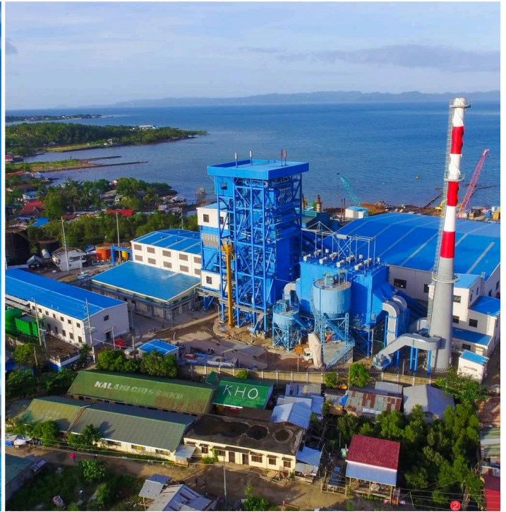
DMCI Masbate Biomass Power Station in Philippines (EPC) 菲律宾 DMCI 马斯巴特生物质电站 (工程总承包)
