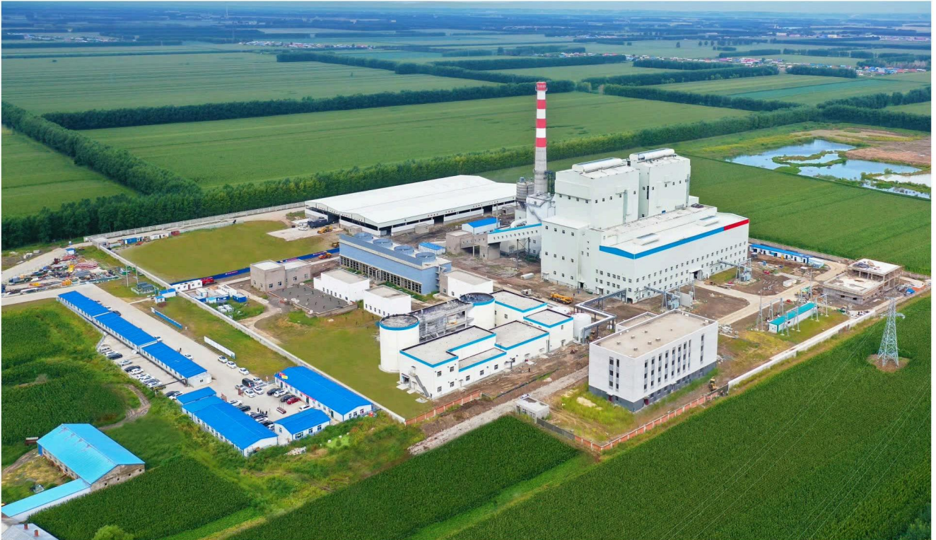
Projeto de Cogeração de Biomassa de Beilin em Heilongjiang, China (Investimento e Construção) 中国黑龙江北林生物质热电联产项目 (投资建设)
