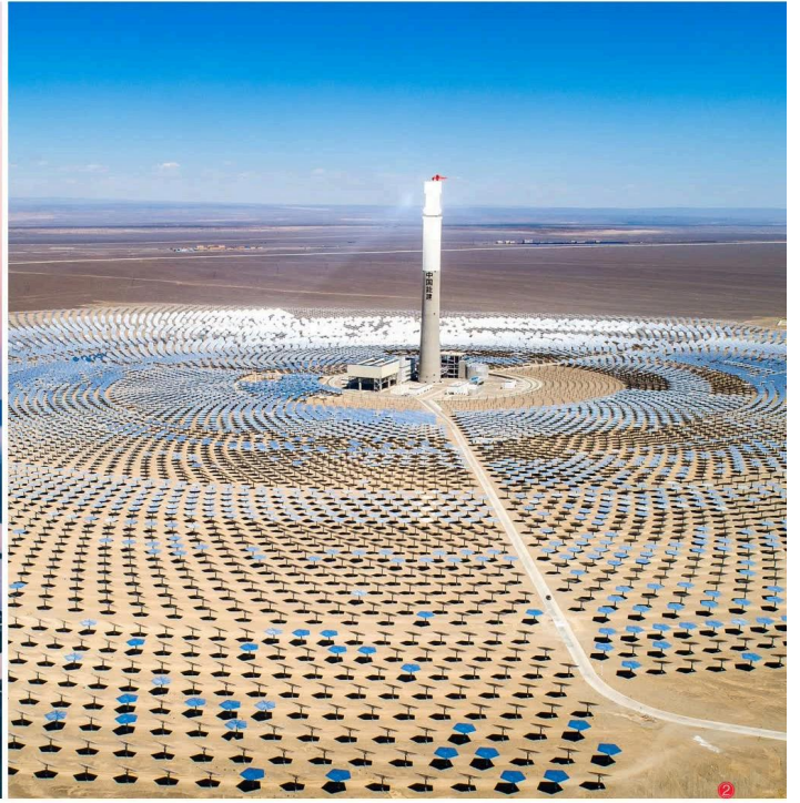
2 Projeto CSP de Torre Central de Sal Fundido de 50 MW em Hami, Xinjiang, China (Investimento e Construção) 中国新疆哈密熔盐塔式 50MW 光热发电项目 (投资建设) Com uma capacidade instalada de 50 MW, é um dos primeiros 20 projetos demonstrativos CSP na China. 50MW, 中国首批 20 个光热示范项目之一。
