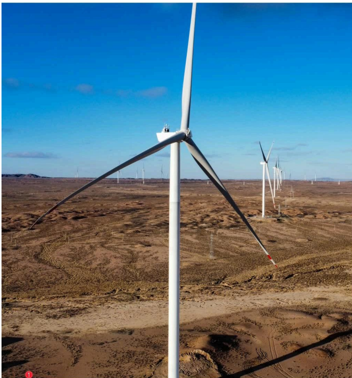
Projeto de Energia Eólica de 300 MW em Bayan Nurug, Alxa Left Banner, China (EPC) 中国阿拉善左旗巴彦诺日公 300MW 风电项目 (工程总承包) 1 Com uma capacidade instalada de 300 MW, é um projeto representativo em "zonas desérticas (Gobi/áridas)". 300MW, "沙戈荒" 典型项目。
