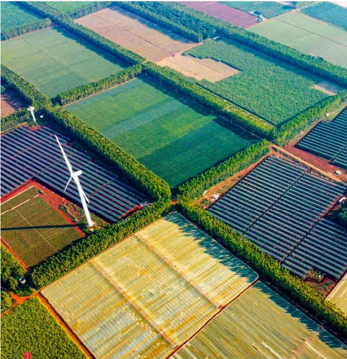
1 Projeto Composto Fotovoltaico da Fazenda de Wuyi, Favorável à Energia, em Guangdong, China (EPC) 中国广东能源友好五一农场光伏复合项目 (工程总承包)
