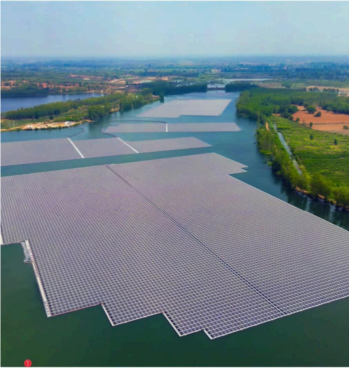
1 Projeto Fotovoltaico Flutuante de 60 MW de Green Lake NPS na Tailândia (EPC) 泰国 NPS 绿湖 60MW 水上漂浮光伏项目 (工程总承包)
