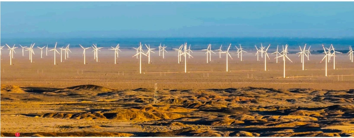
Projeto de "CSP e armazenamento de energia +" de 700 MW em Guazhou, China (Design e Construção) 中国瓜州 700MW "光热储能+" 项目 (设计建设)
