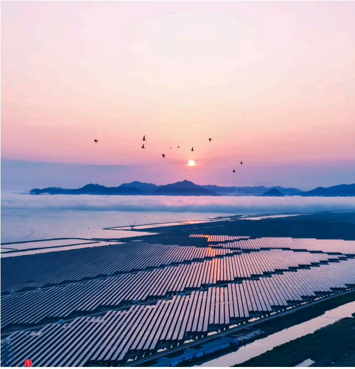
1 Projeto de Integração Aquicultura-Energia Solar de 500 MW em Haiyan, Taishan, Guangdong, China (Participação em Investimento e Construção) 中国广东台山海宴镇 500MW 渔业光伏发电项目 (参与投资建设) Com uma capacidade instalada de 500 MW, é o maior projeto integrado de aquicultura e energia solar fotovoltaica em escala contínua unitária na área da Grande Baía de Guangdong-Hong Kong-Macau. 500MW, 中国粤港澳大湾区单体连片规模最大渔光互补一体化项目。
