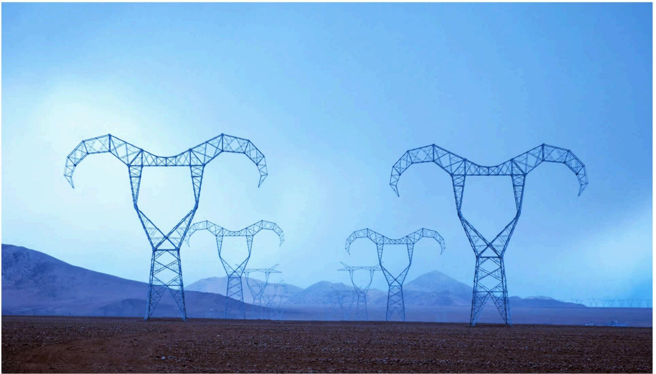
Projeto de Interconexão da Rede Elétrica de Ngari-Tibete Central na China (Design) 中国阿里与藏中电网联网工程 (设计)
